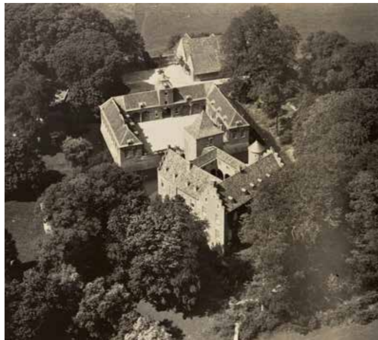
Kasteel Geijsteren, met zuilengalerij en binnenhof. Aan de westkant de voorburcht (met tuinmanswoning, bloemenkamer, timmerwerkplaats, waskeuken en paardenstal) en kasteelboerderij, c. 1925-1935. Noord = rechts. Collectie Nationaal Instituut voor Militaire Historie
